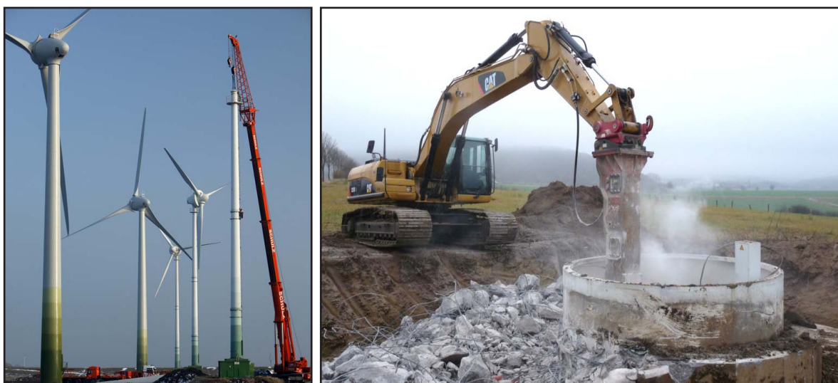
Figure 24: Démantèlement d'une éolienne
