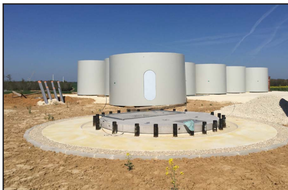
Figure 4: Fondation coulée
